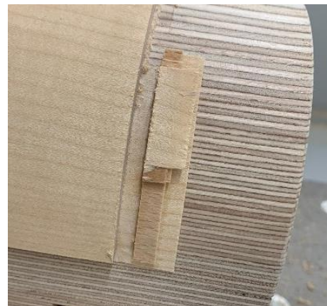
Abbildung: Eigene Aufnahme, Überstand nach Formatierung des Schubkastenbodens
