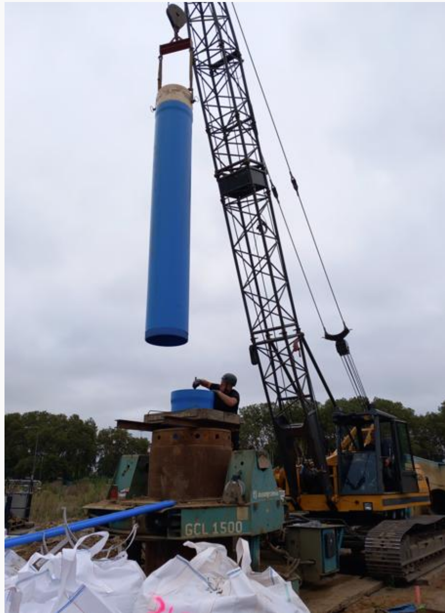
Einbau Brunnenrohr mit Seilbagger
