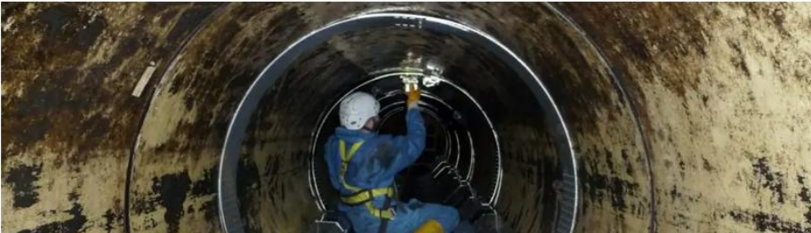
Foto: Avacon Der Abwasserwärmetauscher nimmt die Wärme des durchfließenden Abwassers im Kanal auf.
